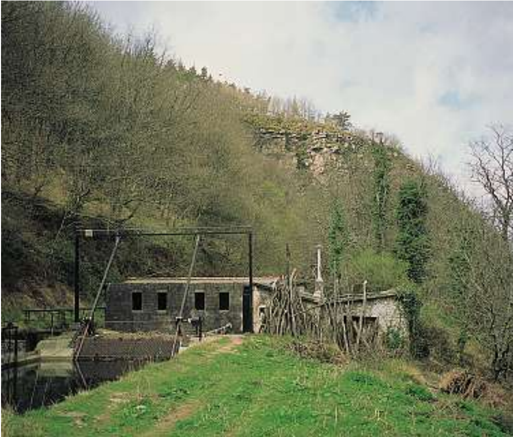
DEPÓSITO DEL CANAL ALTO DE LEITZARAN (VILLABONA)
